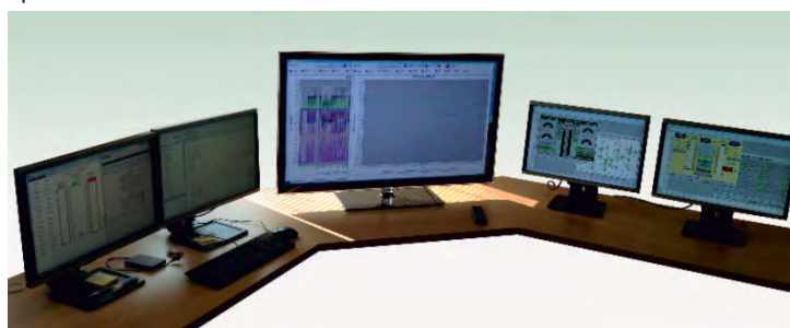
Sistemi vožnje/upravljanja/kočenja, daljinski monitoring,...
